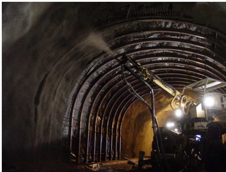
Fig. 7.41 : Projection par robot sur cintres de tunnel.
