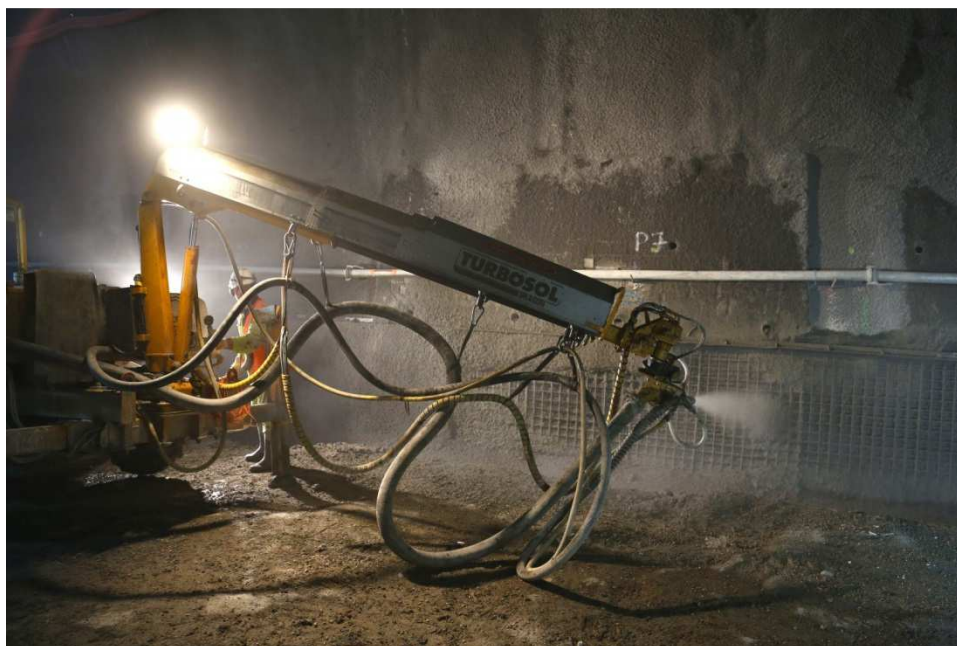
Fig. 7.37 : Renforcement de mur de soutènement
