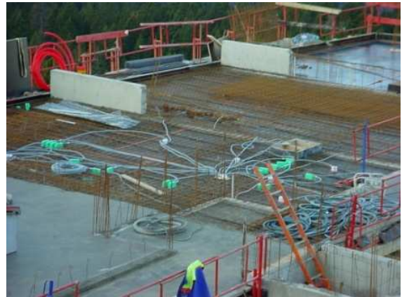
Fig. 2.1a : Les planchers à dalle pleine
