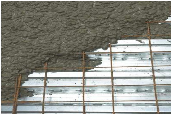
Fig. 2.1b : Les planchers nervurés
